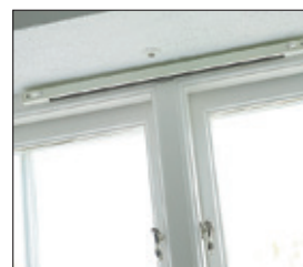
Ventiler Här BIOBE 30, placerad i mitten på karmöverstycket.
